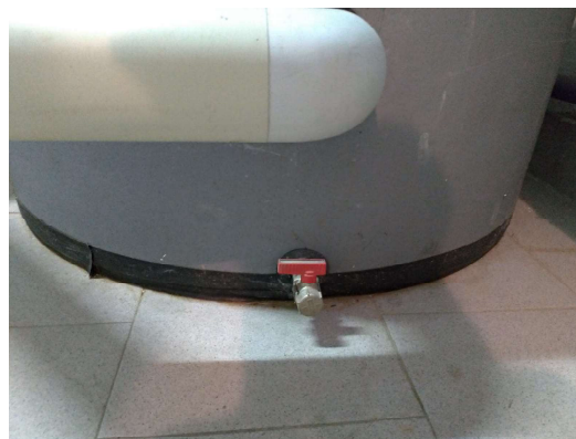
Fig 4 - scarico di fondo serbatoio accumulo acqua calda (attualmente tappato)
